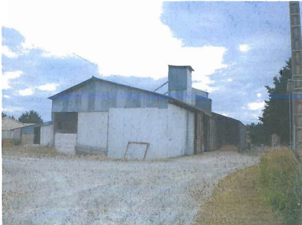
Photo H - Vue sur la FAF et le local d'embarquement (sur la gauche), au niveau de l'entrée principale du site (accès depuis la voie communale n°202).
