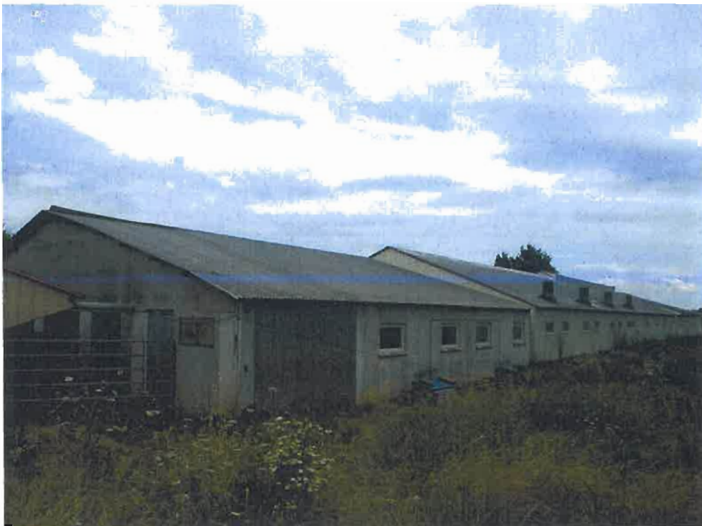
Photo D - Vue vers le sud-est sur le bâtiment de post-sevrage et des reproducteurs.
